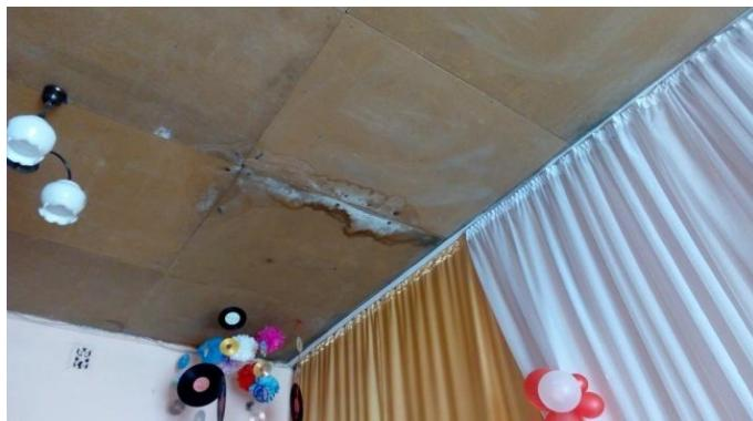
проблемные участки, это подтверждается большим количеством трещин, как на стенах, так и на потолке. В актовом зале ДДТ потолок в плохом состоянии, на это указывают пятна и подтеки, по словам директора это обусловлено плохим состоянием кровли здания, так как во время дождей из крыши сочится вода.
